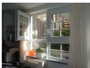
Hybridfenster mit Sprossen (Drehkipplügel oben, Festverglasung unten)
